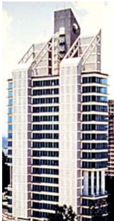
Figura 4.5 – Edifício Alfacon – Alphaville – SP, Catálogo Construção Metálica Cosipa.
