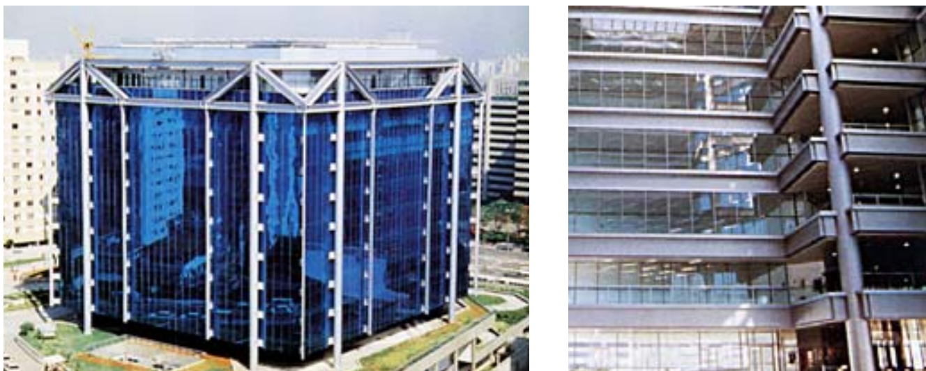
Figura 4.6 – Centro Empresarial do aço: a esquerda vista externa e a direita detalhe interno. Foram empregadas formas estruturais (vigas e tubos) obtidos a partir de aços planos estruturais, Catálogo Construção Metálica.
