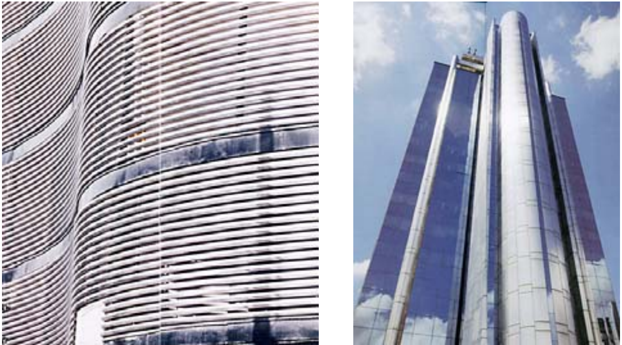
Figura 4.9 – Frente de dois edifícios utilizando aço inoxidável como elemento protetivo e embelezador: à esquerda edifício com a frente formada por tubos de aço inoxidável e à direita outro edifício onde foi utilizado chapas aço inoxidável com a mesma função, Catálogo Acesita.
