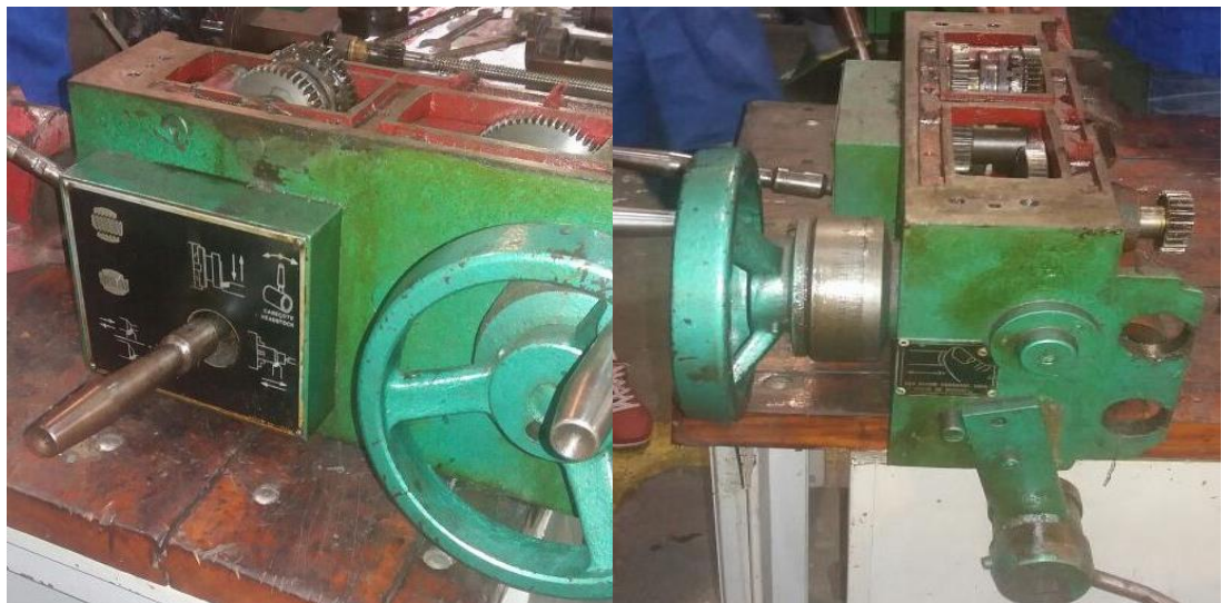
Figura 29 - Avental – Desmontagem e limpeza.
