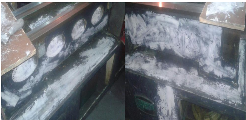
Figura 52 – Aplicação da massa plástica.
