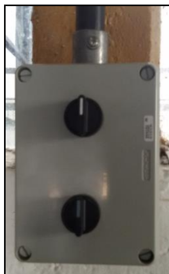
Figura 8 – Detalhe do acionamento dos climatizadores.
