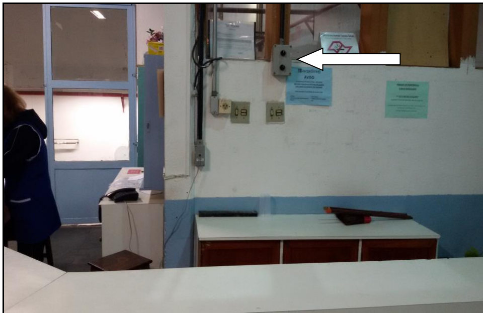
Figura 7 – Localização do acionamento dos climatizadores
