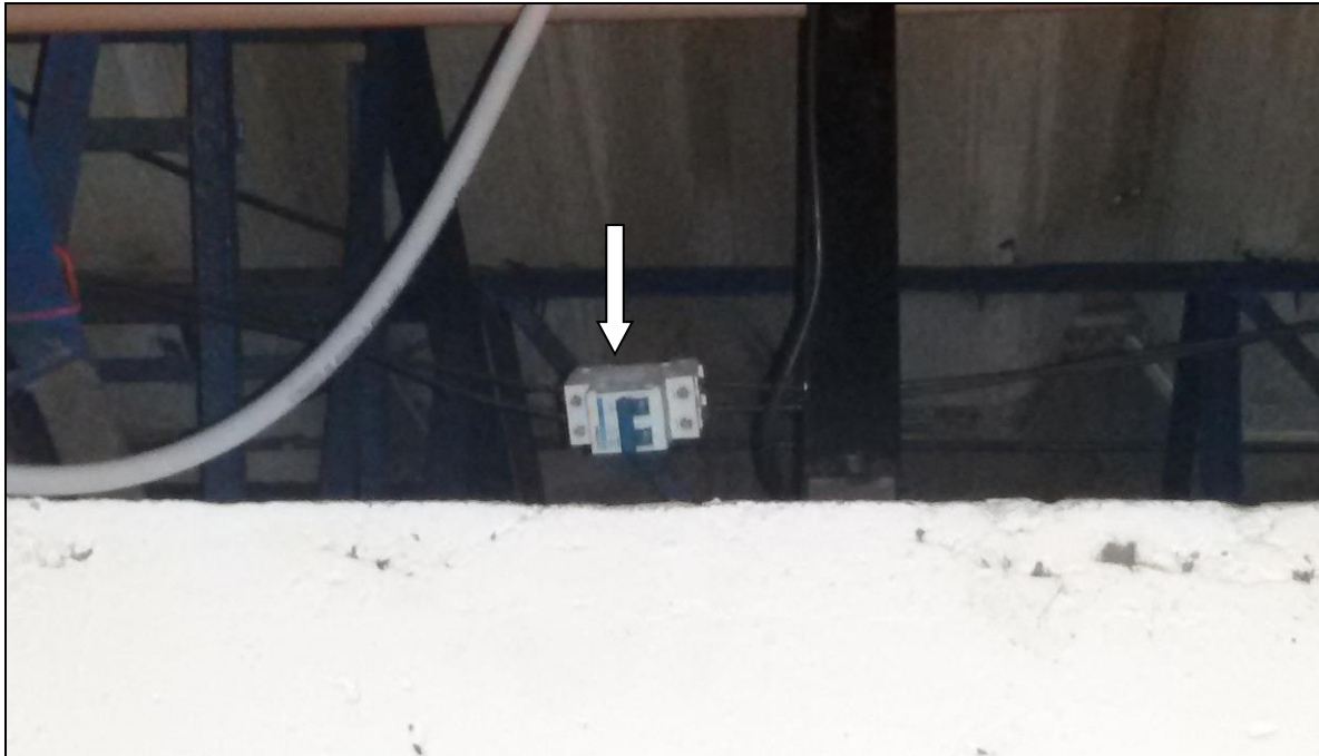
Figura 3 - Disjuntor mal localizado/instalado
