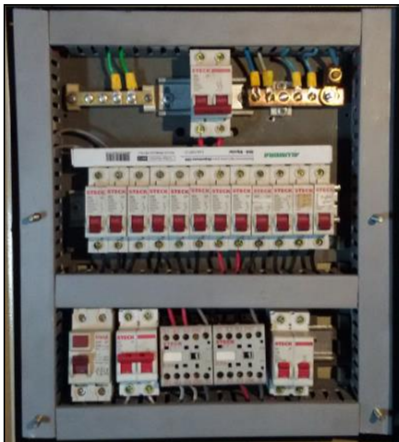
Figura 6 – detalhe do QD com o comando para os climatizadores.
