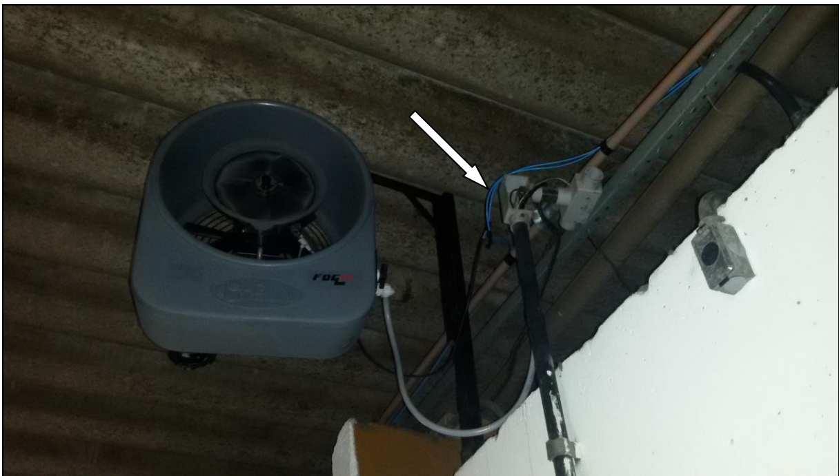
Figura 2 – condutele aberto e condutor fixado em tubulação hidráulica
