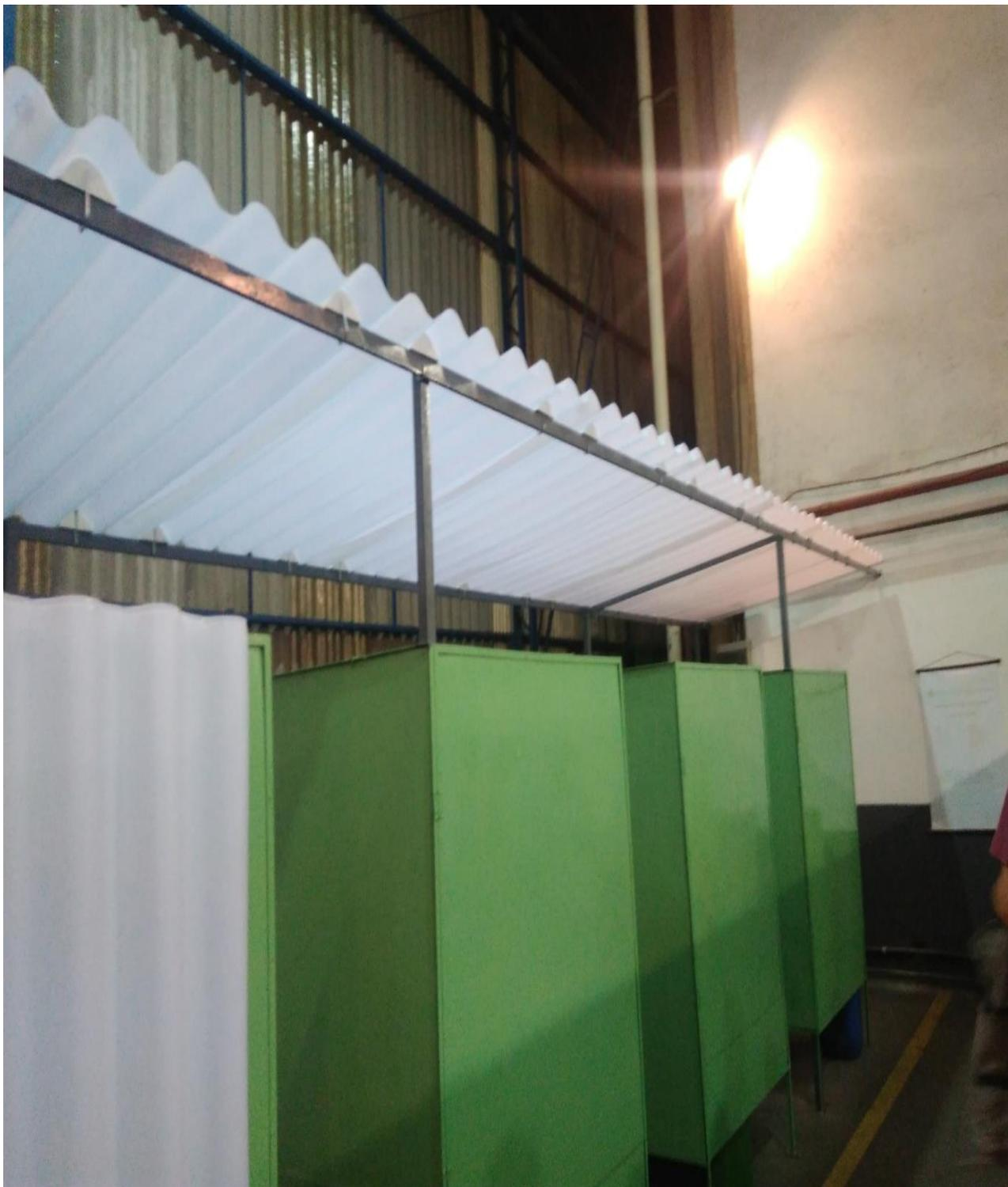
**Figura 6:** Cobertura implantada na célula de solda.
