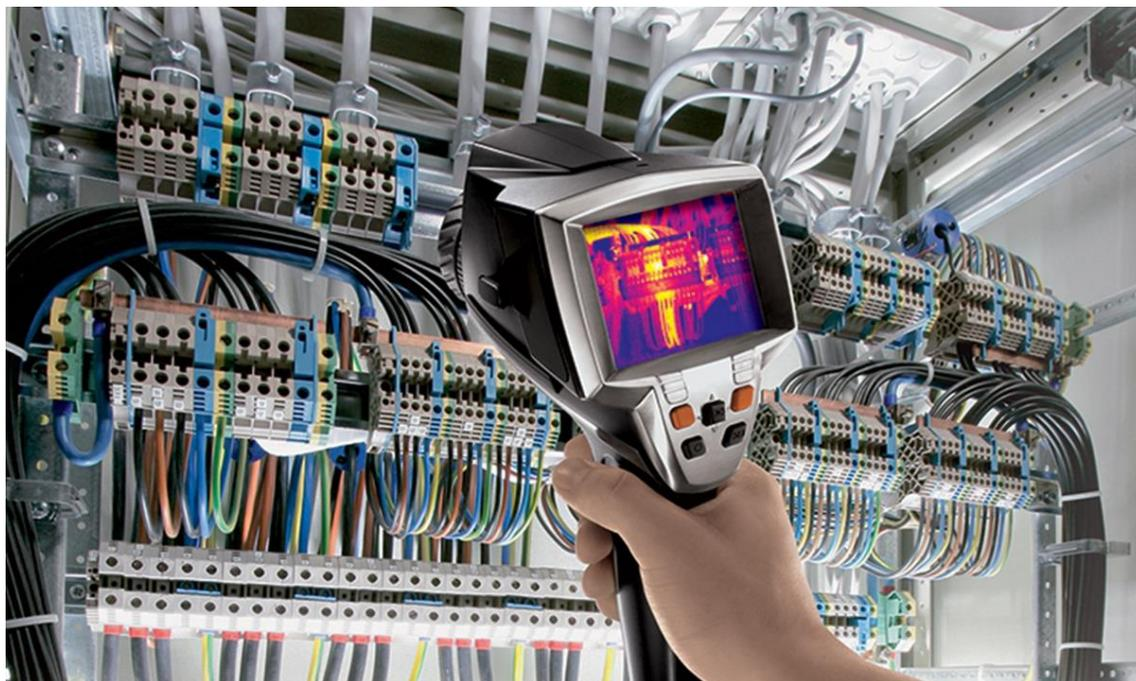
Figura 4 Representação de um processo de Manutenção Preditiva.
