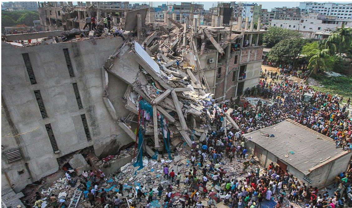
Figura 9 – Desabamento do Edifício Rana Plaza
