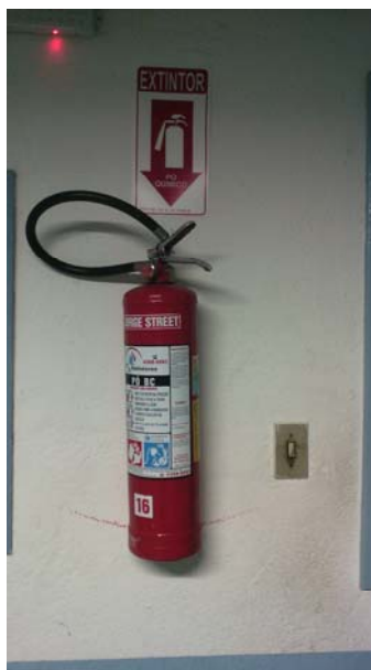
Figura 17 – Extintor existente de pó químico
