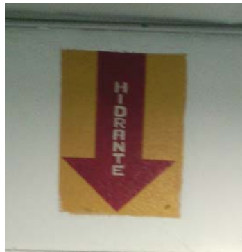
Figura 10 - Placa de indicação a hidrante
