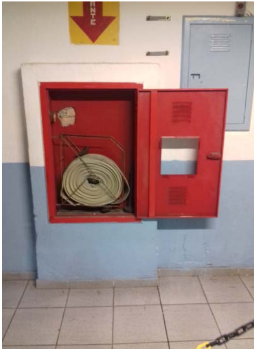
Figura 30 - Estado do hidrante anterior à limpeza (ao lado da entrega da merenda)
