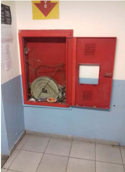
Figura 27 - Estado do hidrante anterior à limpeza (pavimento térreo - ao lado do laboratório 00)
