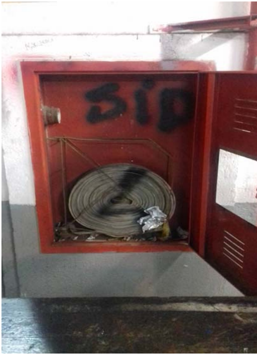
Figura 25 – Estado do hidrante anterior à limpeza (laboratório – área de elétrica)
