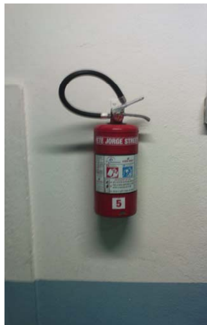
Figura 16 – Extintor existente de pó químico
