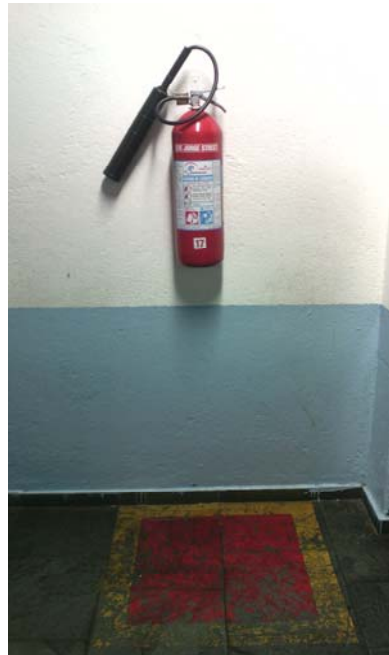
Figura 15 - Extintor existente de água
