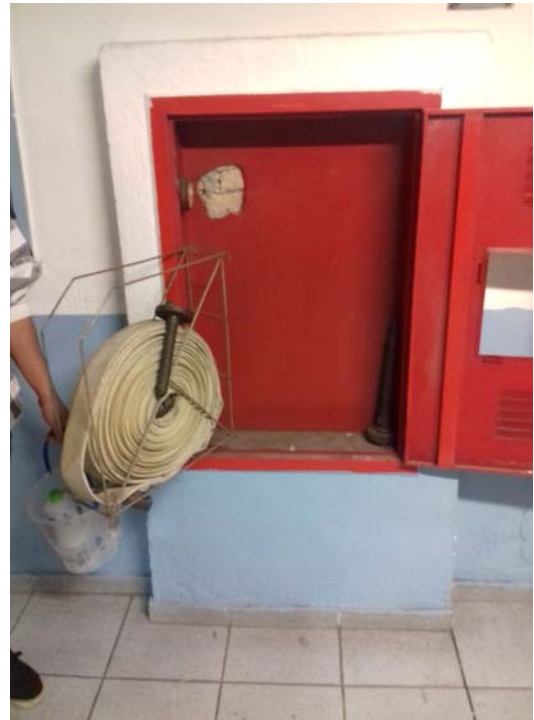
Figura 30 - Estado do hidrante anterior à limpeza (ao lado da entrega da merenda)
